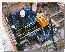
引き込み施工状況
